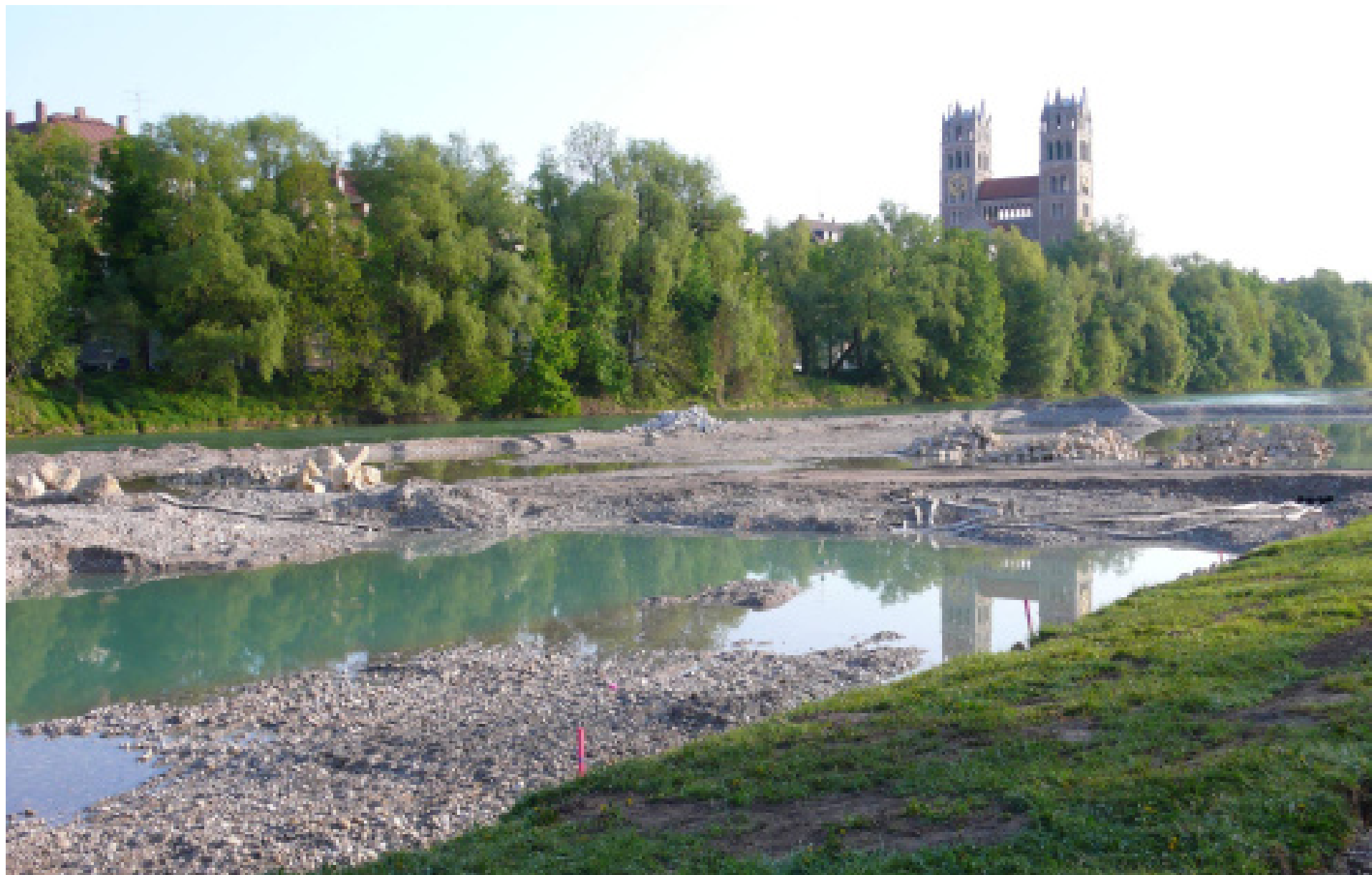
Nejnovější etapa revitalizace Isary v Mnichově (05/2009)
