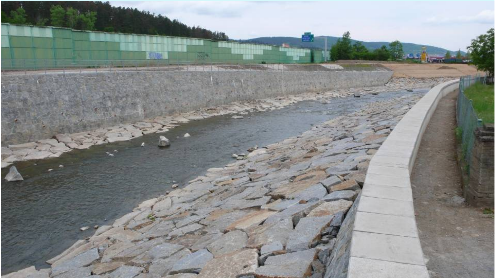
Kontakt koryta Litavky s tělesem dálnice.
