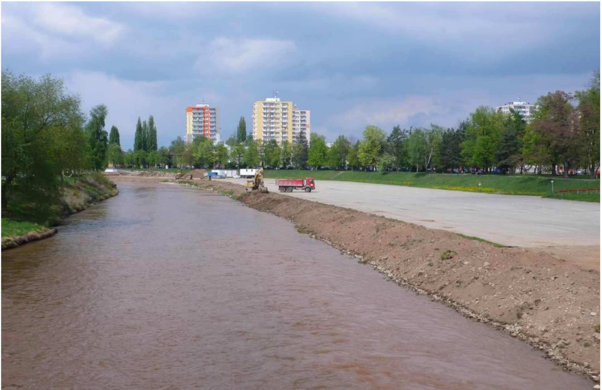
Úpravy plavební dráhy a PPO České Budějovice – tvoření berem v korytě Vltavy
