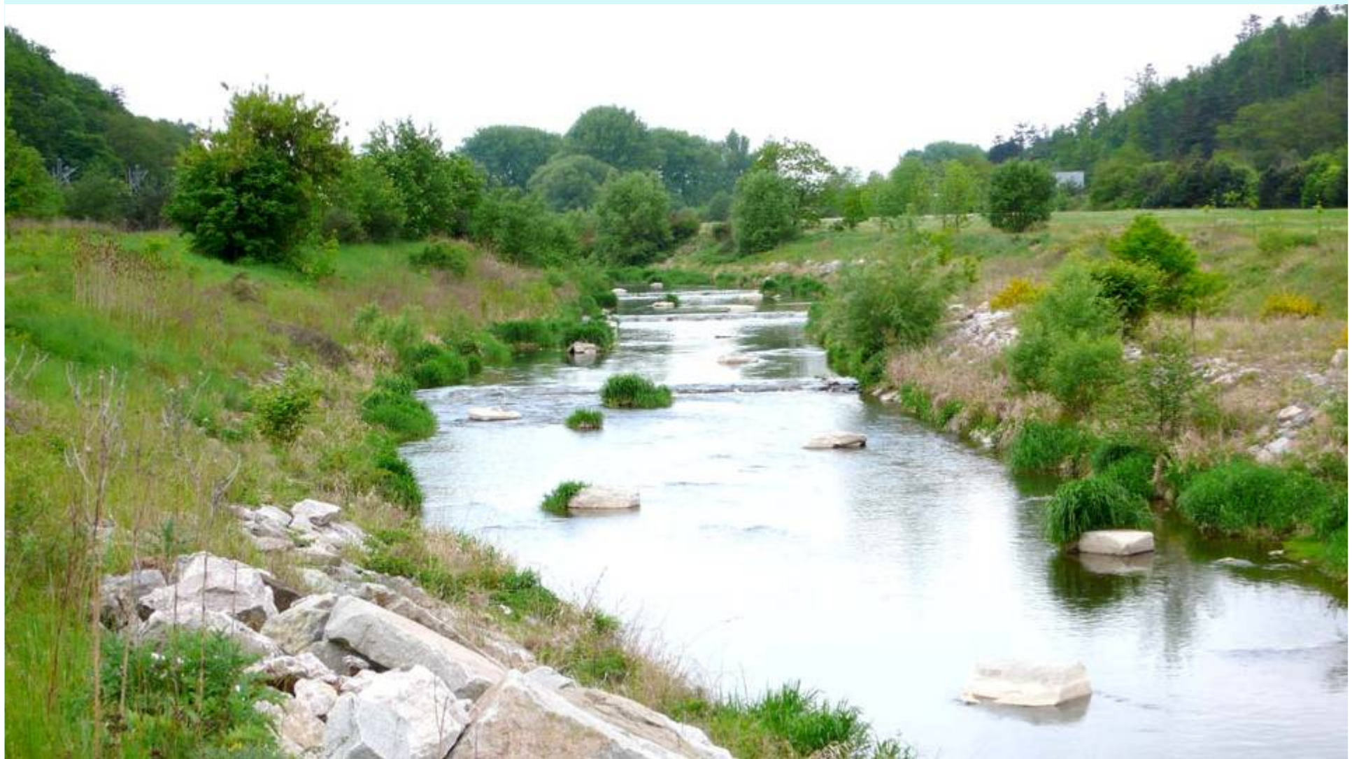
Litavka, Popovice u Králova Dvora, úprava koryta po povodni 2002
